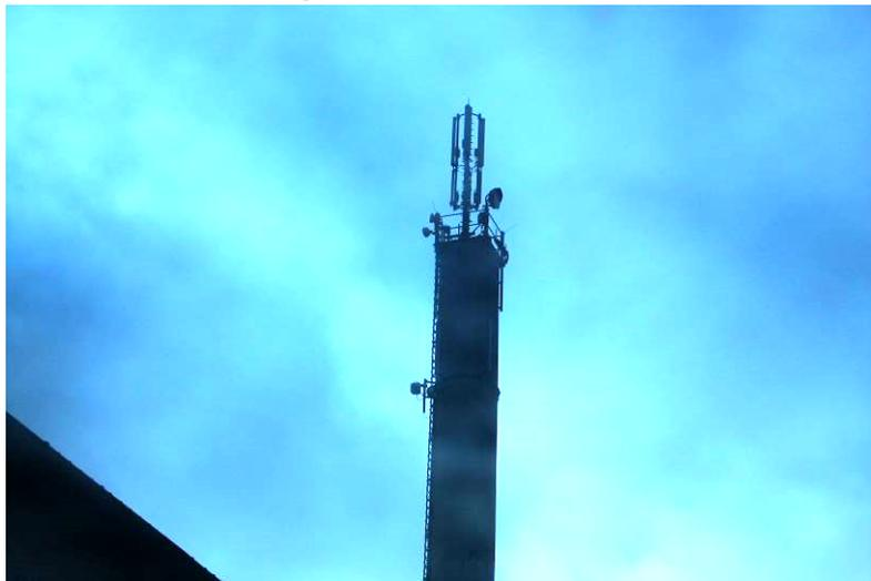
Mobilfunkstandort, noch mit Richtfunkanbindung - Quelle: A. Kaßbohm
